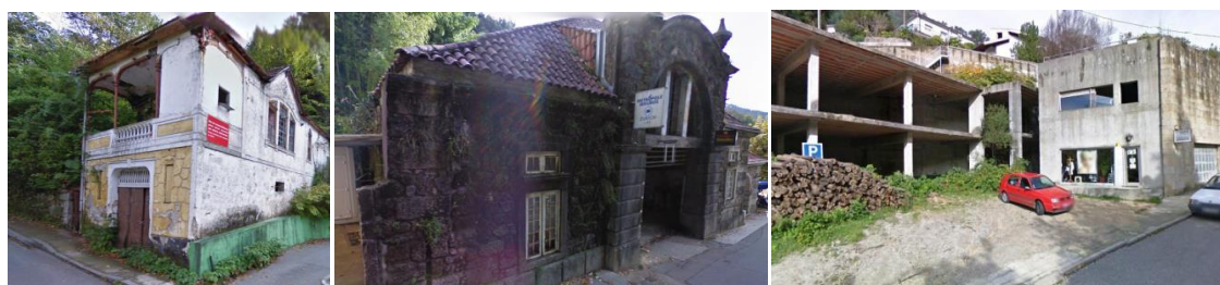
Figura 3. Exemplificação de edifícios degradados na ARU da Vila do Gerês
