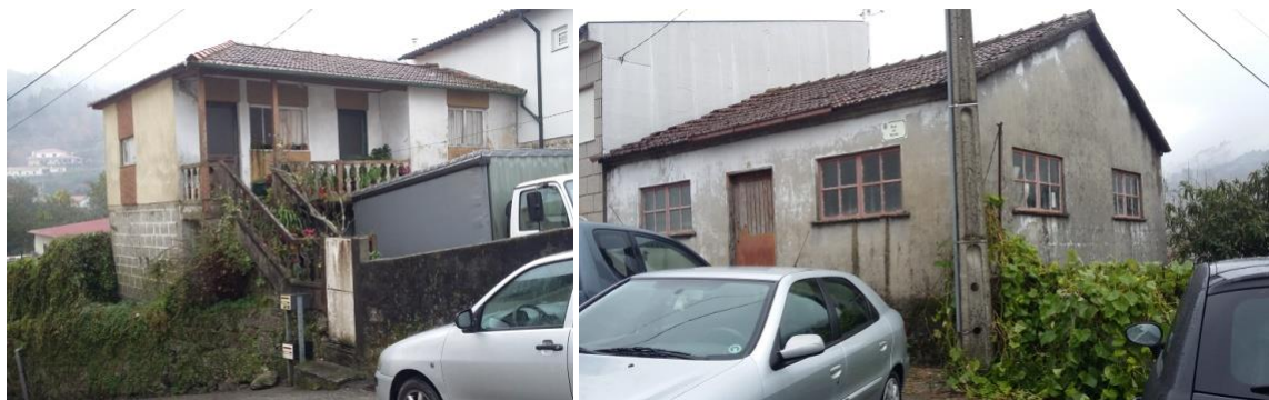
Figura 3. Exemplificação de edifícios bastante degradados na Rua de Brás e Rua do Monte
