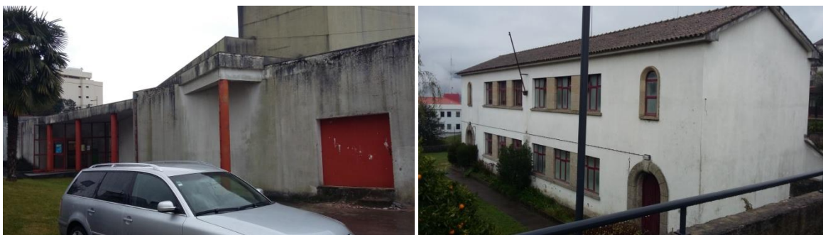
Figura 9. Edifício da Segurança Social (esquerda) e o CMVACL (direita)
