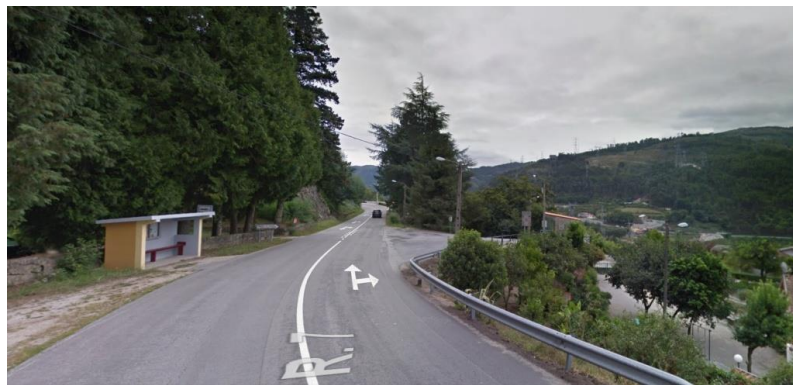
Figura 6. Exemplificação da falta de passeio na ARU do Bairro da EDP
